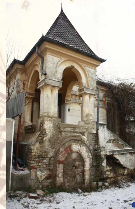
Casa "Castel" de pe strada Deflin, aflată în prezent într-un stadiu avansat de degradare.
