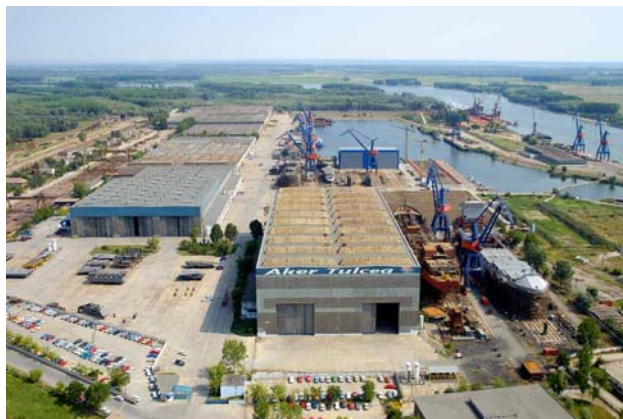
Imagine de ansamblu a Șantierului Naval Tulcea (imagine din arhiva instituției)
