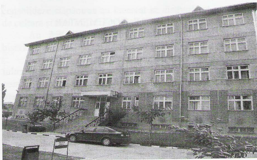
Tronsonul A al clădirii Inspectoratului Județean al Poliției de Frontieră Naval, în care funcționează Direcția Județeană Tulcea
